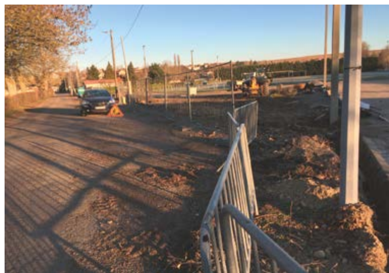
Travaux d'aménagement du stade
