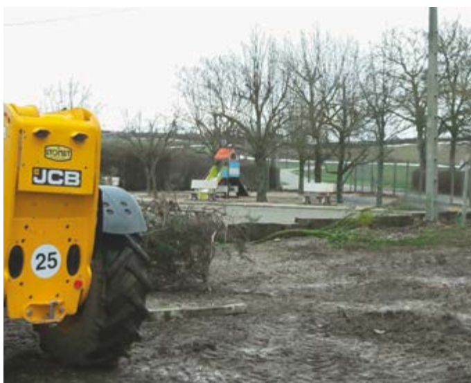
Travaux au stade
