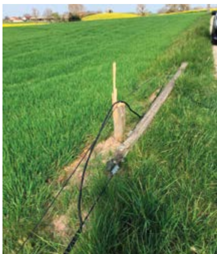
Dégât causé par un engin agricole, qui a privé de réseau 40 foyers !
