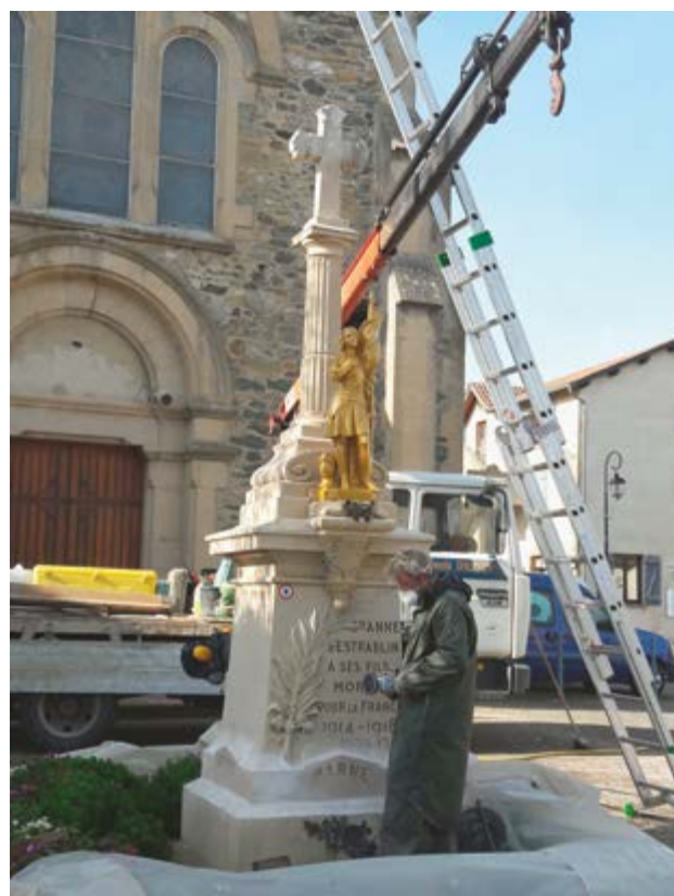
Réfection monument aux morts
