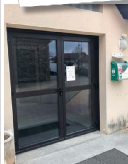
Changement de la porte d'entrée de la salle des fêtes
