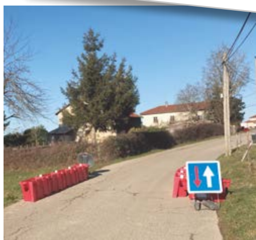
Sécurisation provisoire Montée du Village
