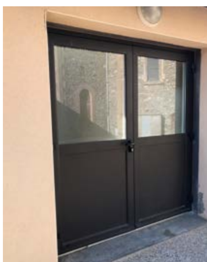
Changement de la porte de la cuisine de la salle des fêtes
