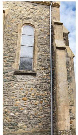
Les descentes d'eaux pluviales ont été remplacées pour limiter les entrées d'infiltration
